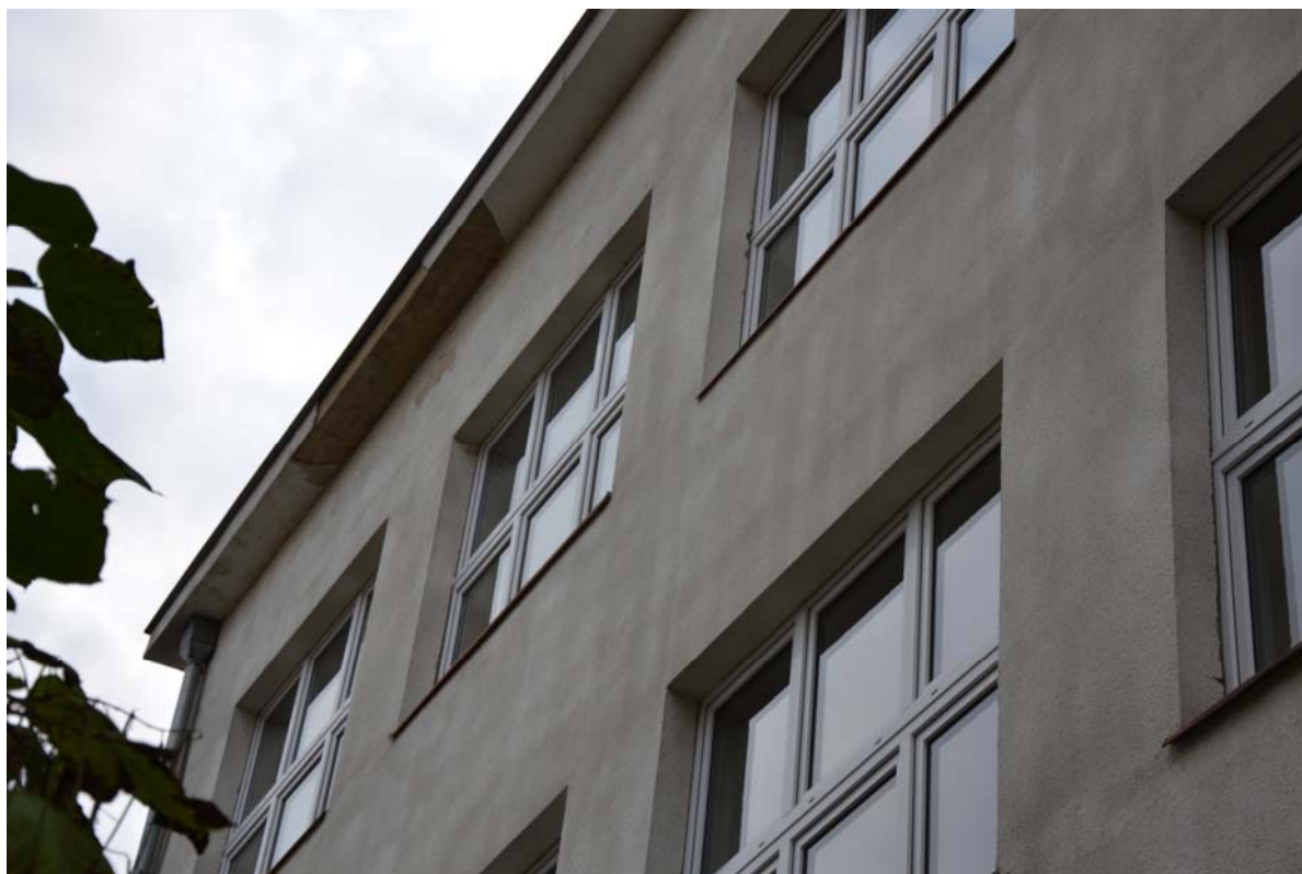
Obr 5: Na jihovýchodní stěně je omítka na několika místech porušena, nicméně neposkytuje hlubší skuliny vhodné pro úkryty netopýrů.
