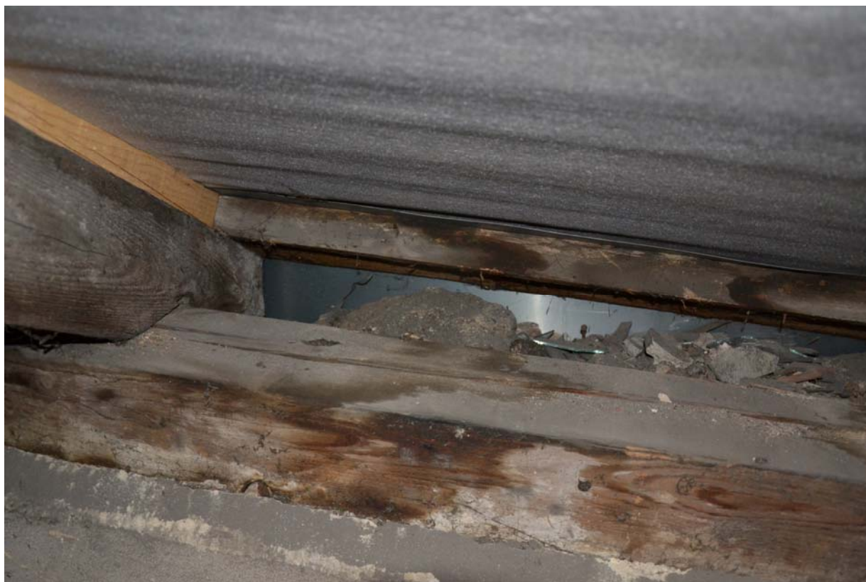
Obr 3: Prostory za pozednicí jsou směrem ven všude uzavřeny.
