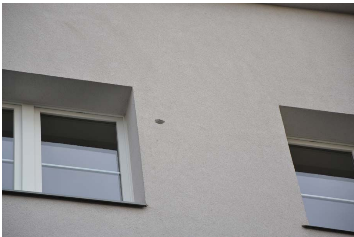
Obr 6: Na severovýchodní zateplené stěně byl zaznamenán otvor vzniklý činností datlovitých ptáků.
